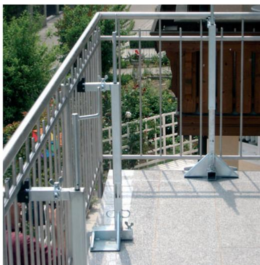
Grâce à ce support de montage, vous pouvez désormais monter balustrades et rambardes d'escalier en toute simplicité. Le montage nécessite moins de temps et d'énergie, car il peut être réalisé par une seule personne, une fois l'objet croché dans les supports.
